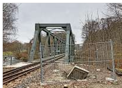
Die Neißerbrücke in Hirschfelde ist derzeit von beiden Uferseiten abgezäunt – im Vordergrund der aufgeborene Kabelschacht.
